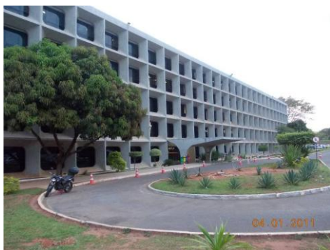
Figura 1.20 – vista lateral do prédio Anexo
