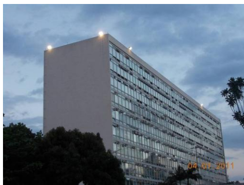
Figura 1.1 – fachada típica - leste
