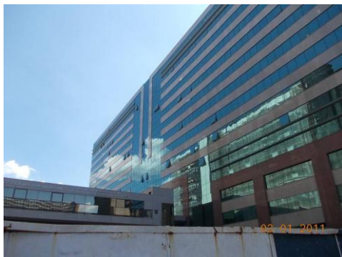
Figura 1.26 – vista da fachada lateral do prédio
