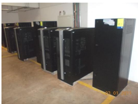
Figura 1.33 – no-break utilizado pelos equipamentos de informática
