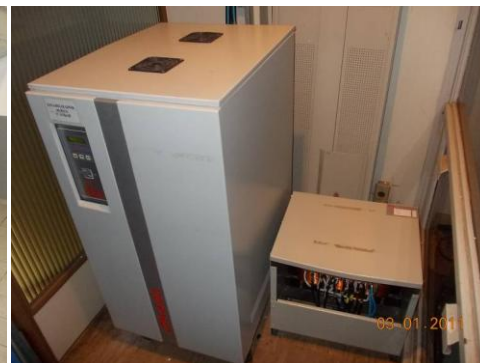
Figura 1.9 – estabilizador utilizado pelos equipamentos de informática
